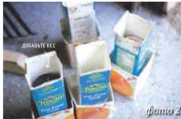
Просверливаем отверстия для дренажа в нижней части коробок, пока раствор не сильно схватился. Окончательно раствор затвердеет через 24 часа (фото 3).
