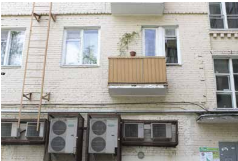
Кондеры гонят горячий воздух к жильцам. Балконные ограждения нагреваются очень сильно
